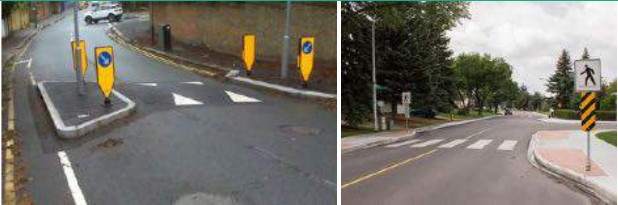
Figura 179 - Restringimento di carreggiata
